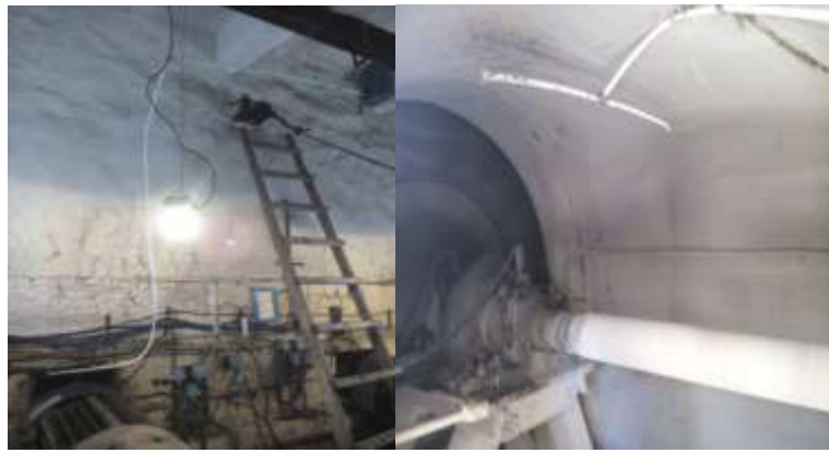
Рисунок 13 - Монтаж пристрою зрошування ВГП
